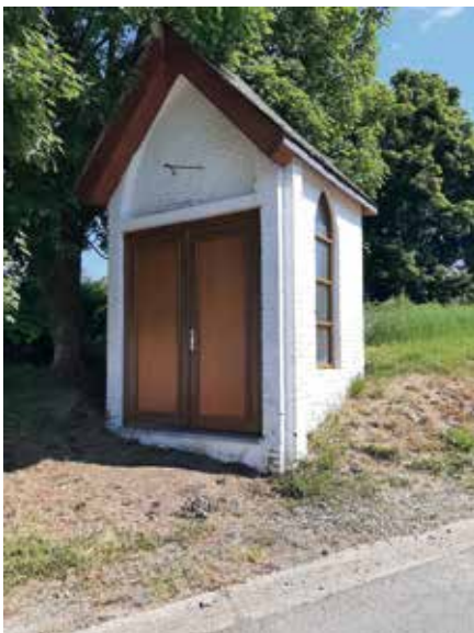
Réparation à la chapelle de Feschaux
