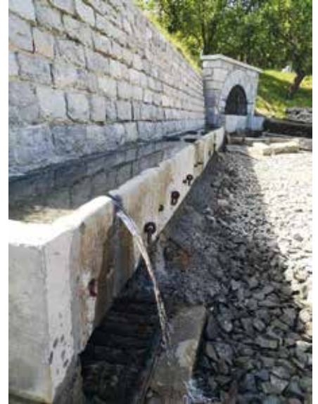
Rénovation de la fontaine de Neuville
