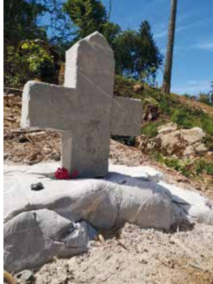
Réhabilitation de la Croix du Castel St Pierre
